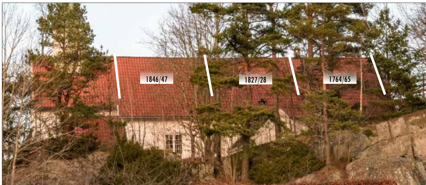
Kirka sett fra sør, altså sjøsida.
