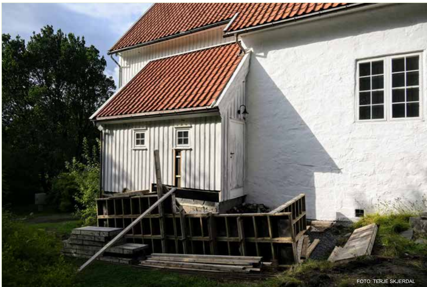
Slik så det ut på byggeplassen 26. august.
