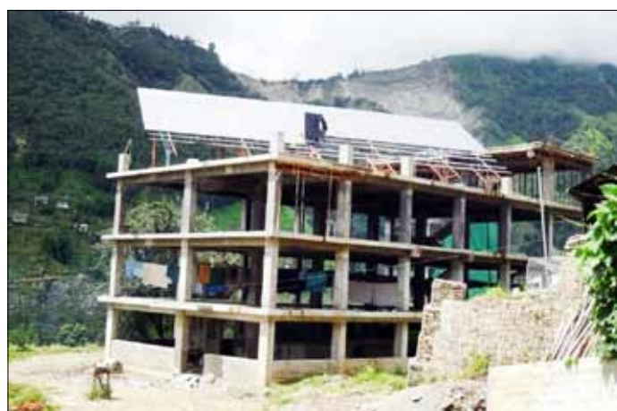
Hele taket på den nye sykehusbygningen skal dekkes av solceller. Det nasjonale strømmettet er ustabil, og diesel til generatorene er dyrt. Solceller kan være løsningen!
